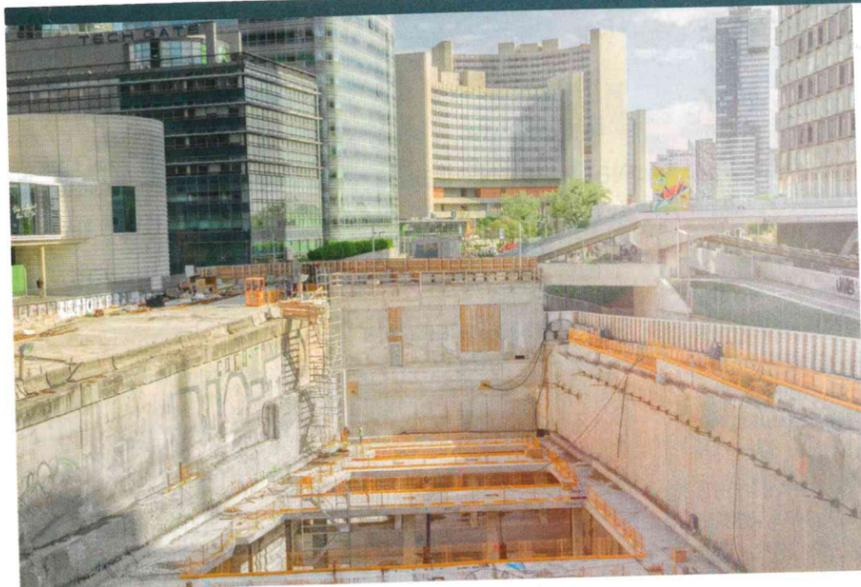
Für den DC Tower 2 in Wien hat sich das Spezialtiefbauteam der Porr 22,7 Meter in die Tiefe gegraben und damit ein sicheres Fundament für den Turm geschaffen.
